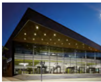
60 Vogtlandhalle (Stadthalle), Greiz/DE
